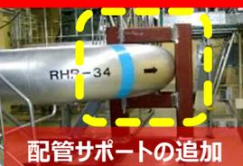
建屋内の配管等のサポート（支え）を各号機1,400～3,000箇所追加。中越沖地震以降から実施してきており、基準地震動への適合も確認。
