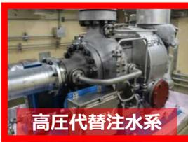
全ての電源を失った場合でも原子炉の蒸気を駆動源に原子炉へ注水。
