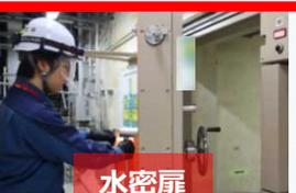
事故時に炉心を冷やす装置や、非常用電源等、重要な設備がある部屋には、浸水から守るため水密扉を設置。
