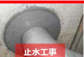
重要な設備がある部屋への浸水を防ぐため、配管やケーブル等が壁を貫通している部分を止水処理。
