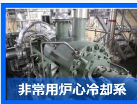
電源駆動のポンプや原子炉の蒸気を駆動源としたポンプを用いて原子炉へ注水。
