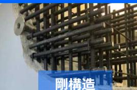
原子炉建屋は、一般の建物より太い鉄筋や厚い壁を使い、大きな力を受けても変形しにくい構造で建設。
