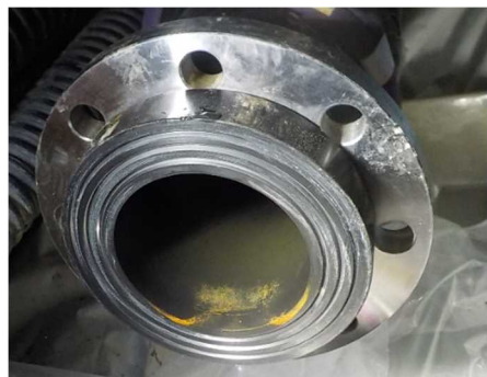
写真a：PE管フランジ部
