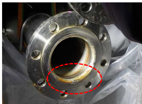
写真b：T字管フランジ部
