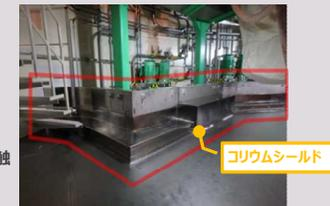
過酷事故発生時に溶融燃料と原子炉格納容器が接触することを防止するコリウムシールドを設置【7号機】
