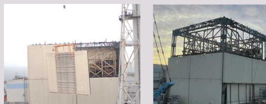
壁パネル吊り下ろし
