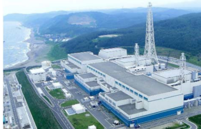
柏崎刈羽原子力発電所
