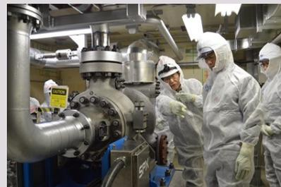
7号機 高圧代替注水系ポンプの設置（柏崎市長視察時）
