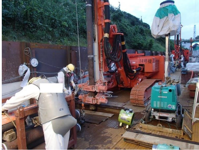
図-4 ボーリング削孔（イメージ）
