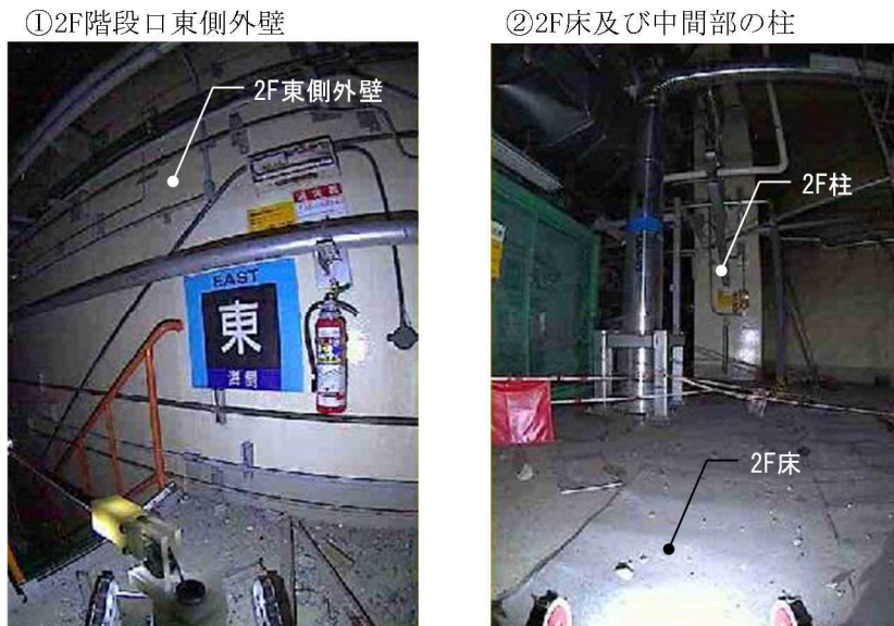
図-2.4(1) 建屋内状況写真（2階）
