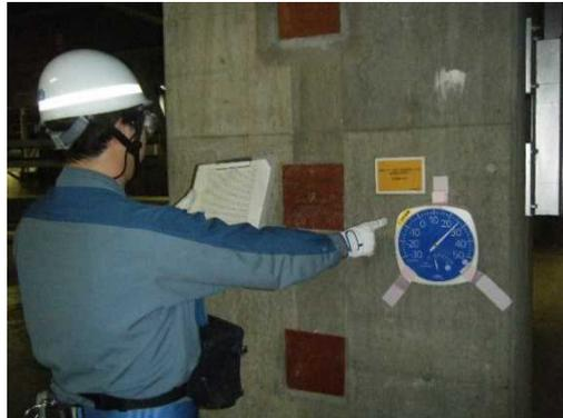
ケーブルトレイエリアへの温度・湿度計の設置
