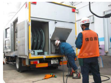
電源車の接続訓練の様子
