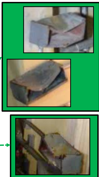
プルボックスの変形状況 （下向きに変形）
