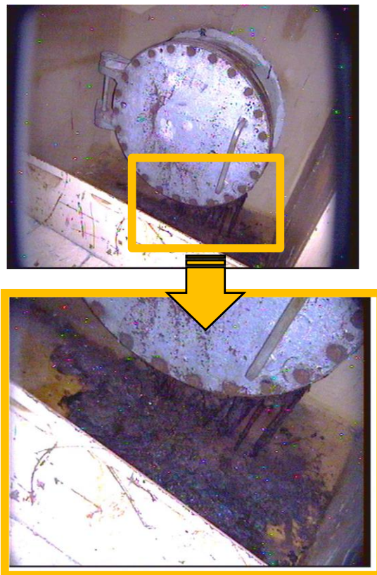
図 3-13 ペネトレーションフランジ部の溶融物の写真[27]
