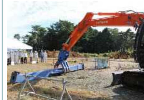
瓦礫撤去直営訓練（福島第二）
