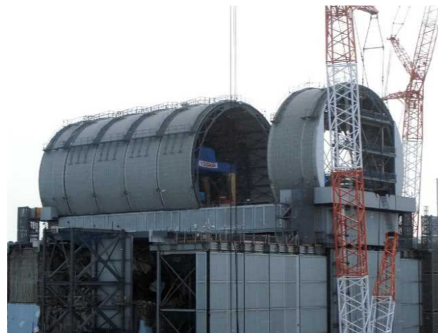
3号機 燃料取り出し用ドーム屋根設置作業（12月12日）
