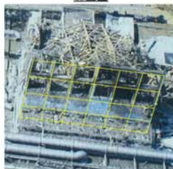
②東面 外壁
