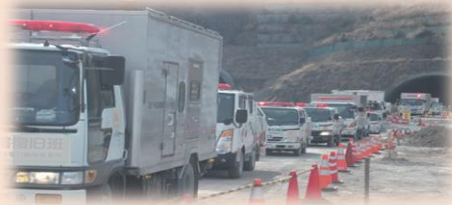
緊急開口部の活用
