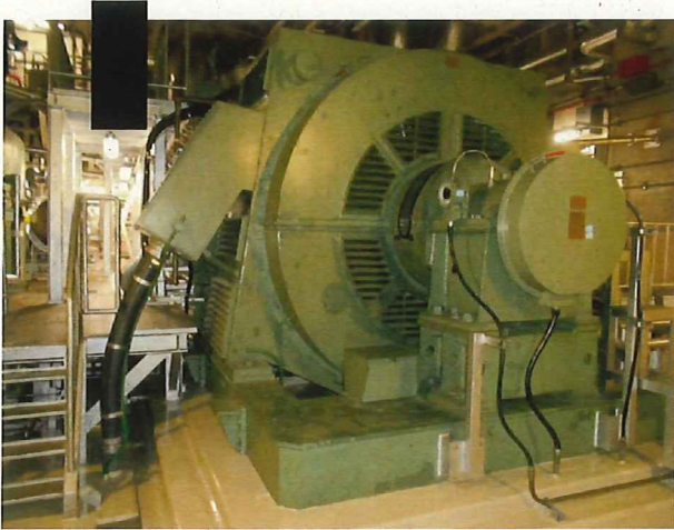
発電機全体外観
