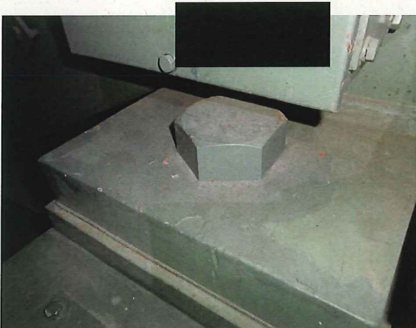
発電機本体基礎ボルト①
