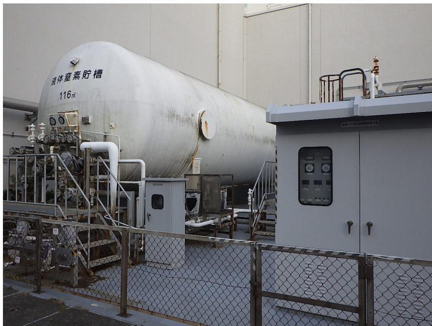
＜格納容器内ガス濃度制御系＞
