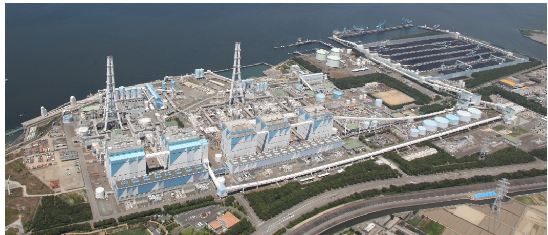
碧南火力発電所 (写真提供:株式会社JERA)
