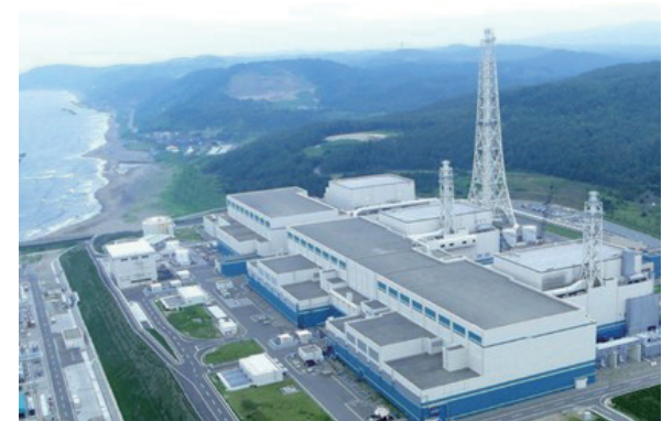
柏崎刈羽原子力発電所
