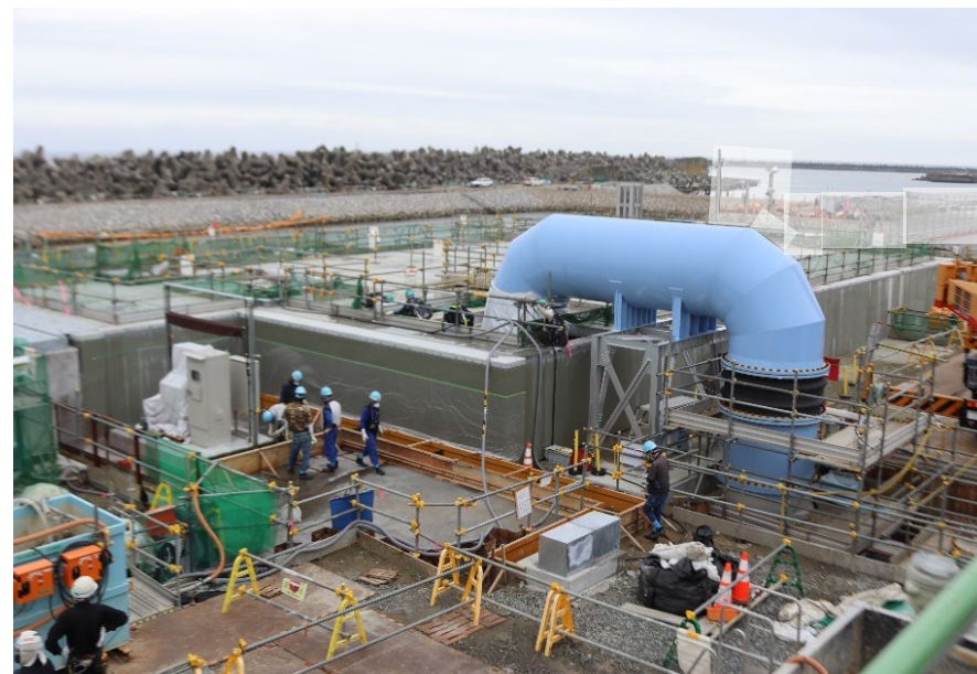
放水立坑（上流水槽）全景 [2023年6月23日撮影]
