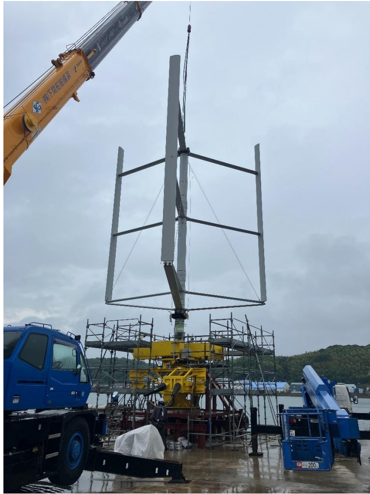
浮遊軸型風車（FAWT）小型実験機 陸上試験
