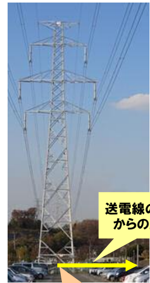
送電線の中心
