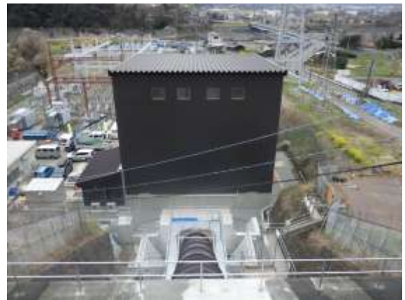
水圧鉄管・発電所（工事後）
