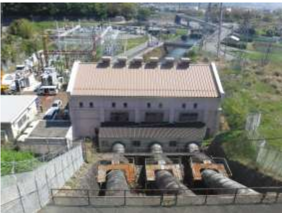
水圧鉄管・発電所（工事前）
