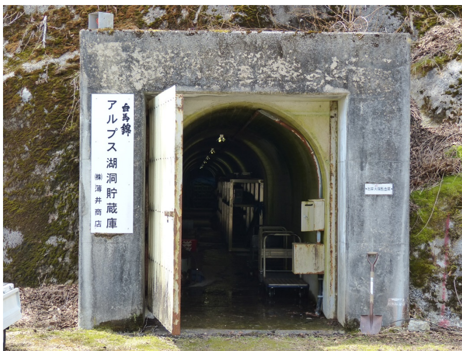
七倉ダムの右岸側にあるトンネル
