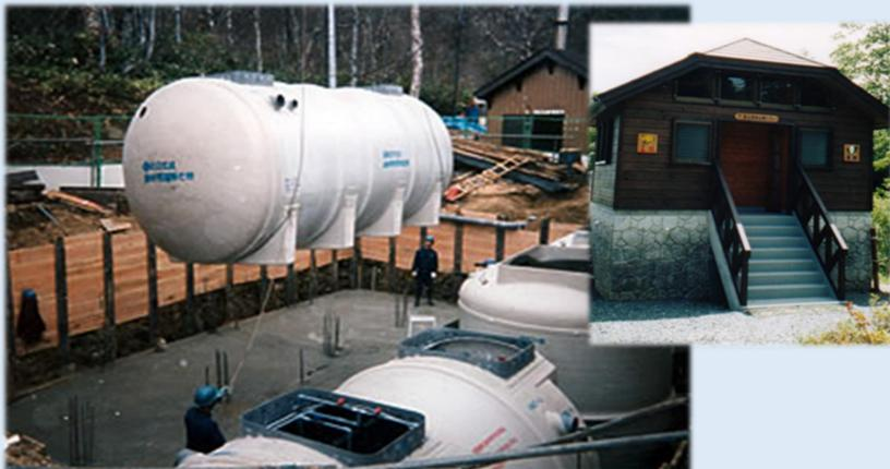
公衆トイレや山小屋には浄化槽を設置しています。河川の魚類や水生昆虫などの生物多様性に影響のない水質に浄化し、排水しています。
