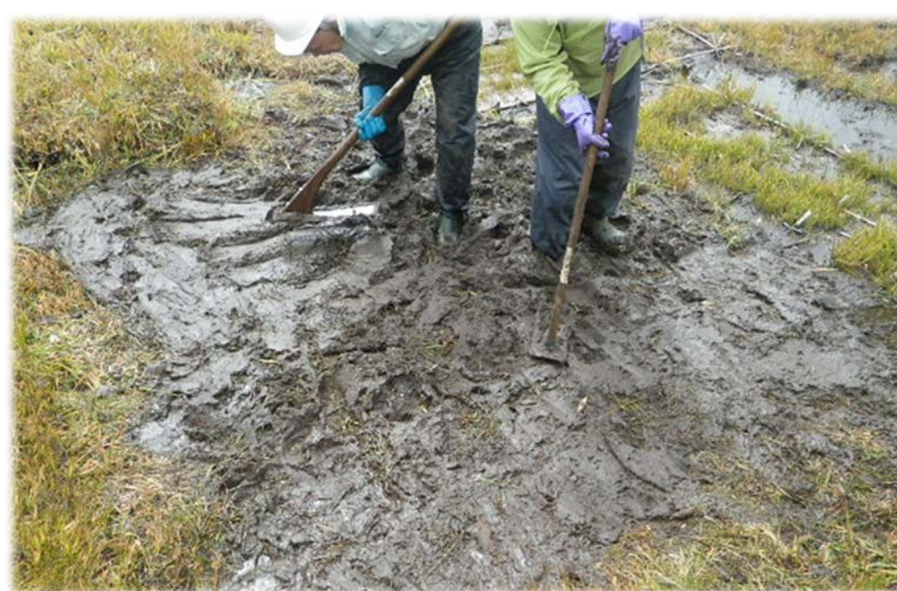
凹地に盛土をする
