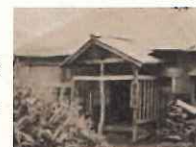
昔の東電小屋（1927年建設）
