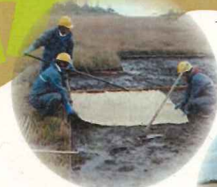
④ まいた種子が風に飛ばされたり、流されたりしないようわらごもで覆います
