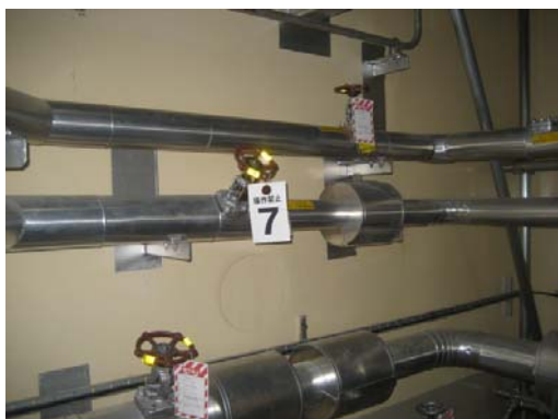
作業エリア（RHRポンプ室）
