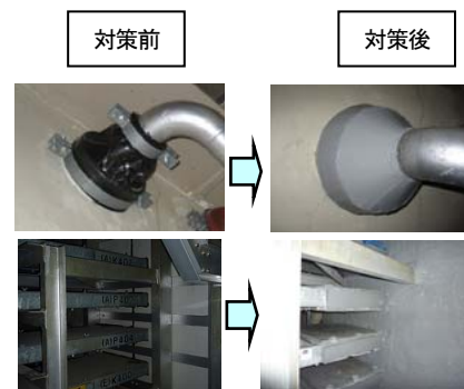
配管貫通部の止水処理施工例
