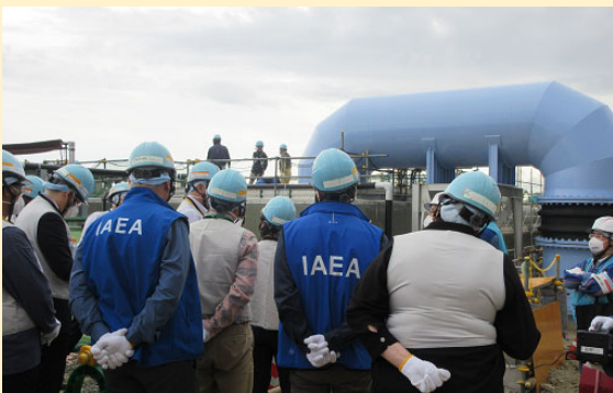
輸送、稀釋設備的視察 (2023年10月25日 福島第一核電廠)
