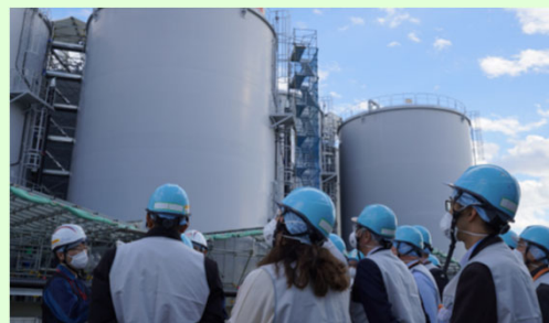
視察測量、確認專用的儲槽群
